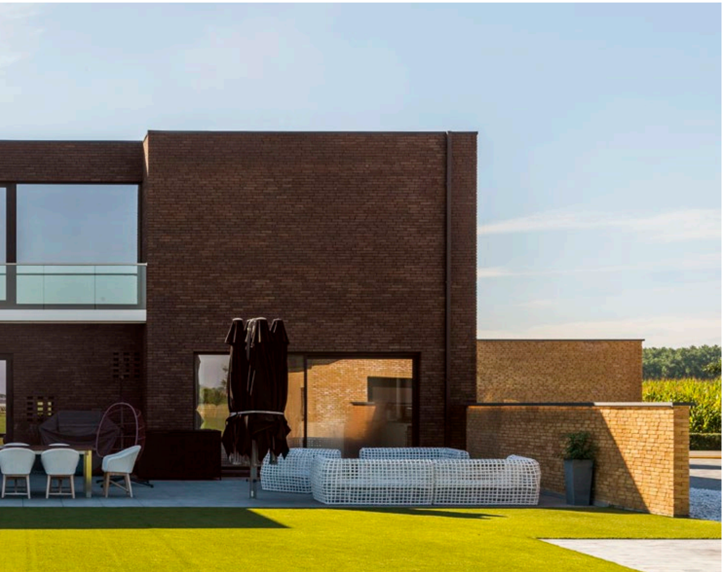
Architectenbureau Tyberghien & Partners, Gent
