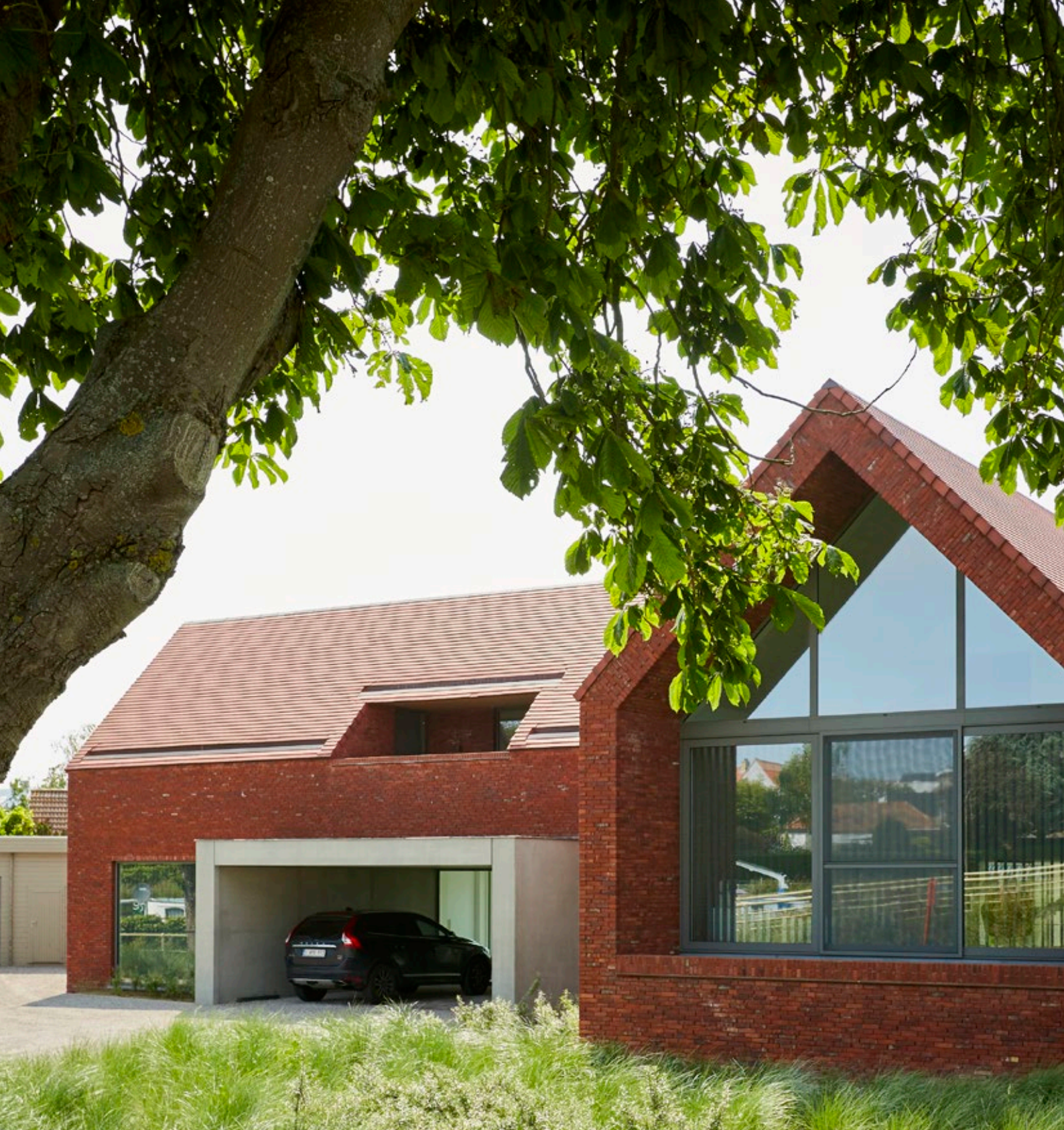
Gevel: Artiza Hectic / Dak: Koramic Tegelpan 301 Amaranat
