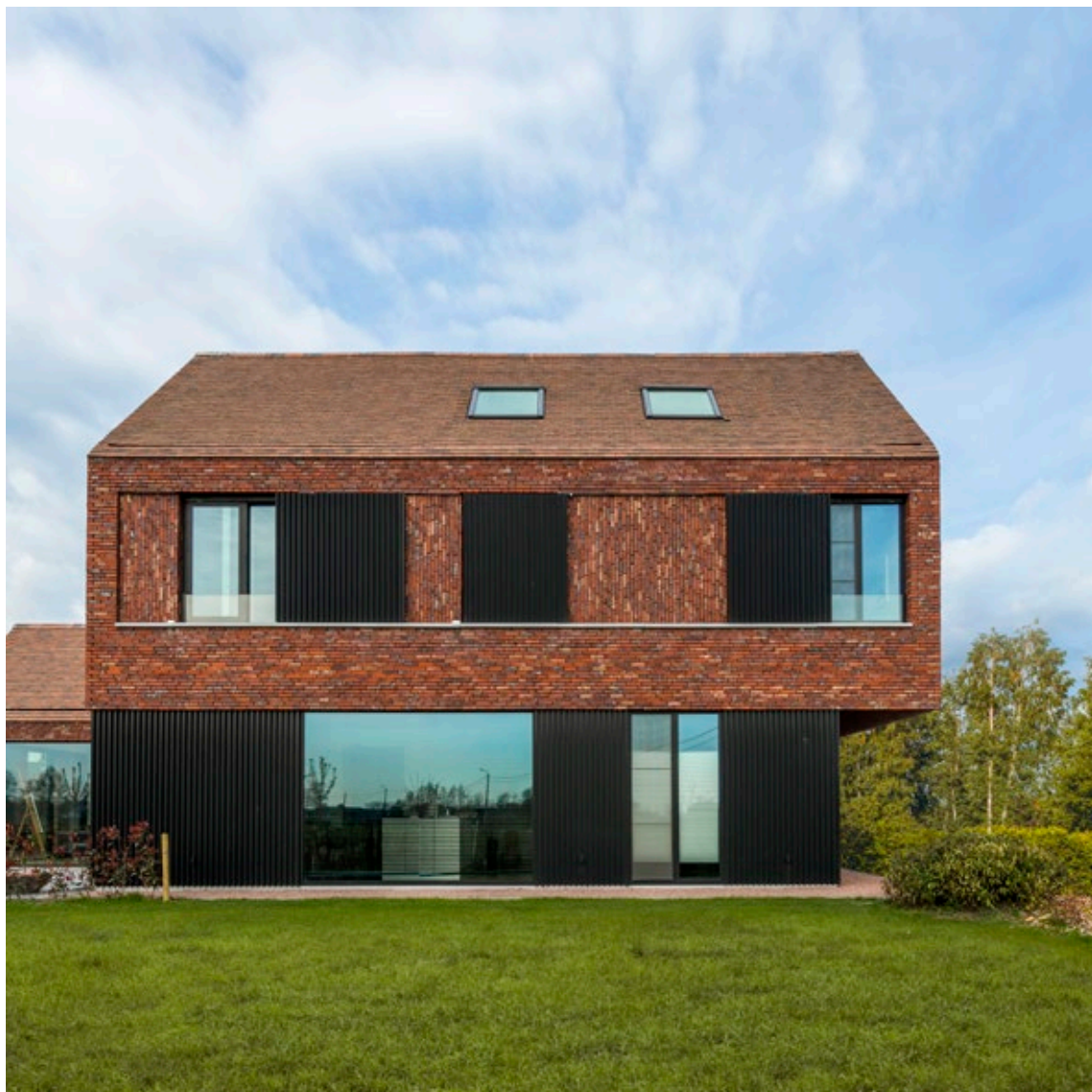
Gevel: Artiza Hectic / Dak: tile-mix van Koramic Tegelpan Aleonard Esprit Patrimoine Rouge de Mars, Noir de vigne en Vert de lichen
