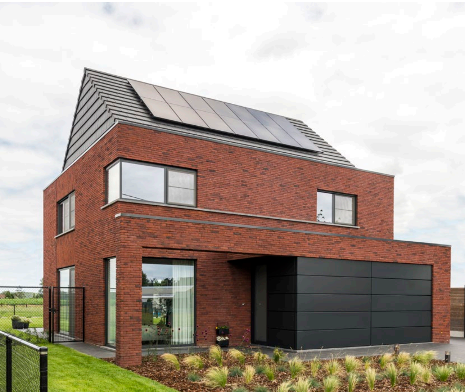
Gevel: Forum Pampas / Dak: Koramic Actua 10 Antraciet mat
