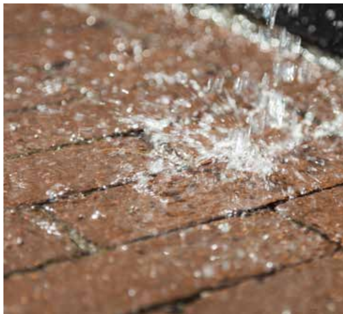
Waterpasserende kleiklinkers werden toegepast in De Duurzame Wijk. Het zijn de voorlopers van de huidige Passaqua ( www.deduurzamewijk.be )
