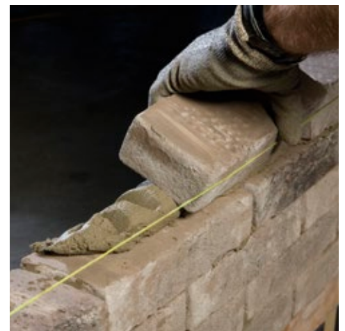
Omdat de overtollige mortel gemakkelijk weg kan, kunnen de stenen zonder veel correctiewerk uiterst precies worden geplaatst.
