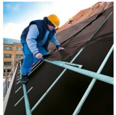
Omwille van zijn hoge UV-stabiliteit is Fleece Maxi uiterst geschikt als onderdakfolie bij recuperatiepannen. Die laten ter hoogte van de overlappings meestal veel zonlicht door.
