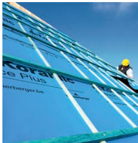
Door zijn speciale coating is Fleece Plus beter bestand tegen temperatuurschommelingen en UV-stralen dan traditionele onderdakfolies. Bovendien is de folie capillair.
