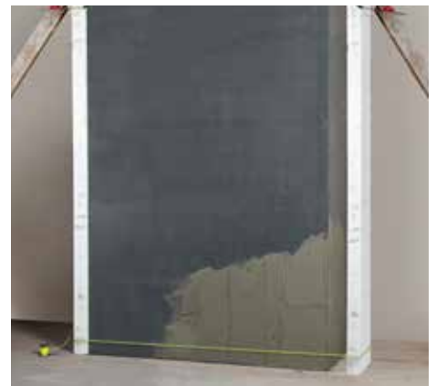
Correct geplaatste maatprofielen vergemakkelijken de verwerking.
