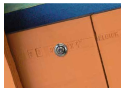
Inox Torx schroef met EPDM-ring 4,5x35 mm voor tegelpannen
