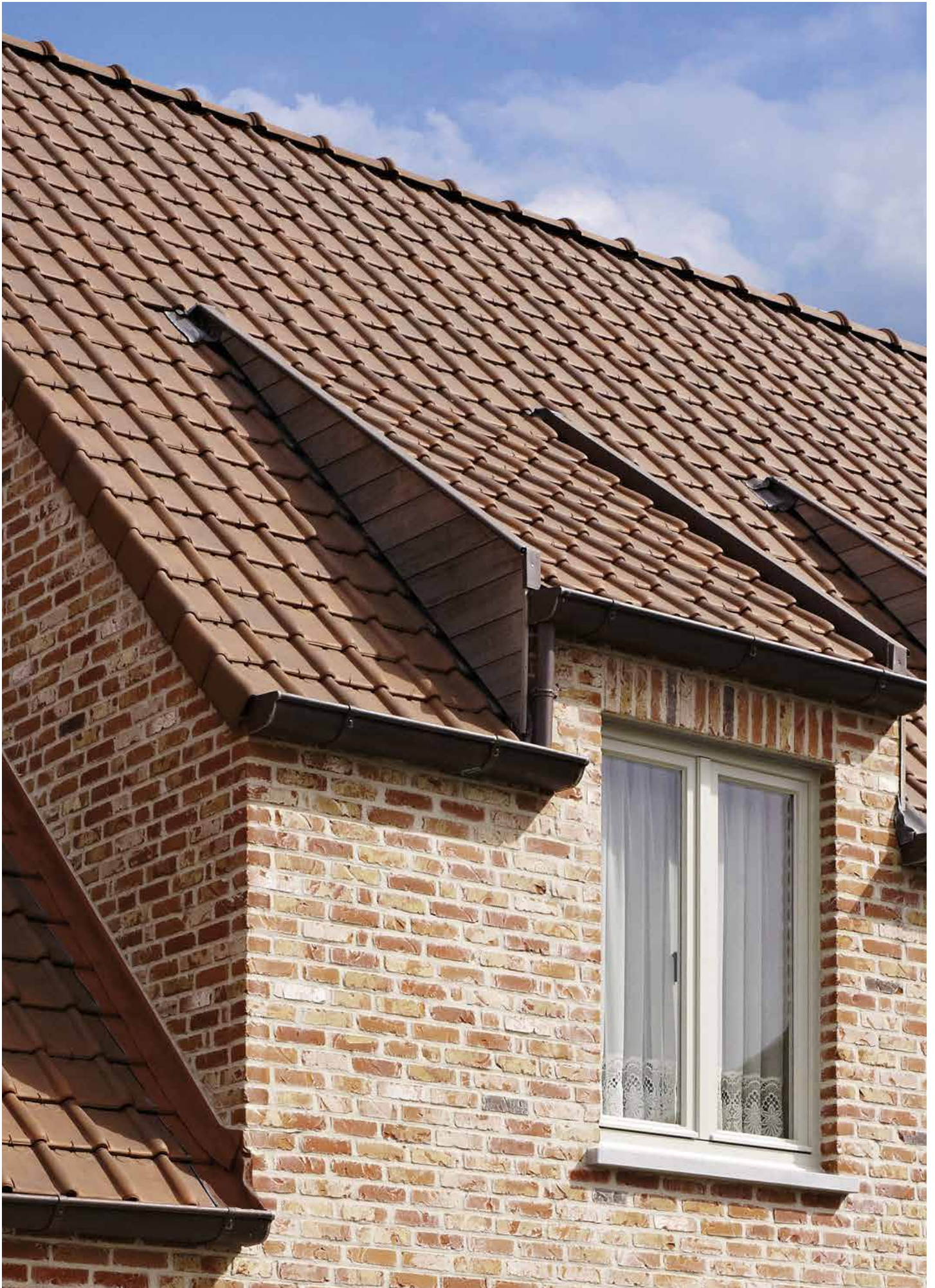
Stormpan 44 Rustiek: verankering van de pannen door gebruik van zichtbare panhaken
