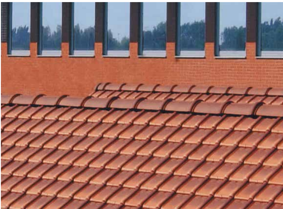
Gebruik van Koramic ventilerende ondervorsten onder vorsten met sluiting
