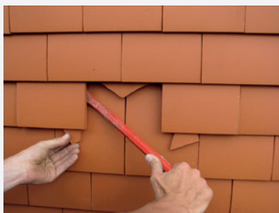
2. Hef de omringende pannen lichtjes op en spie die d.m.v. afstandshouders (bv. d.m.v. de brokstukken van de gebroken pan).
