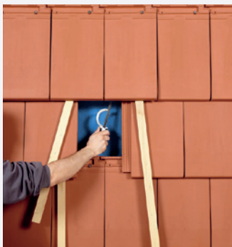
4. Verwijder de bevestigingen (bv. d.m.v. een ijzerzaag).
