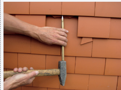
3a. Verwijder met beitel en hamer de resterende keramische delen. Enkel de metalen bevestigingen blijven nog zitten.
