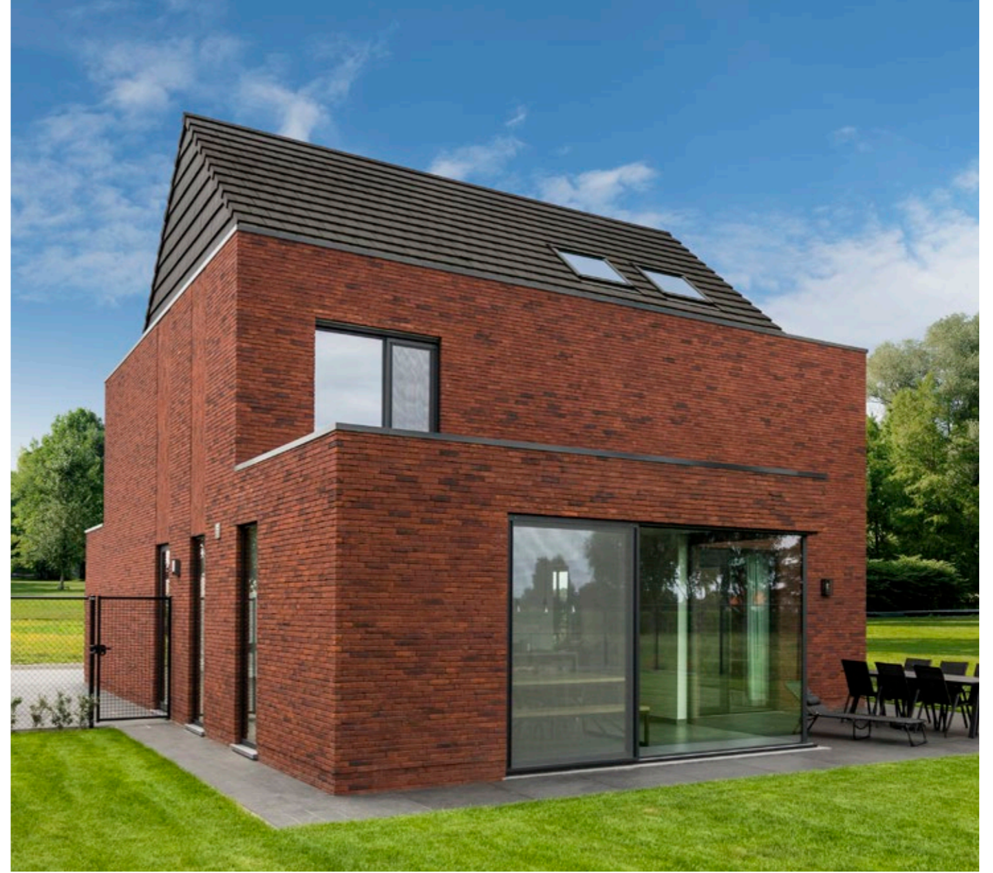
Gevel: Forum Pampas Dak: Actua 10 Antraciet mat Architektenburo Acke - Van Wynsberghe, Assenede
