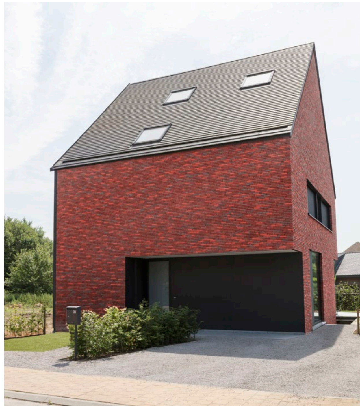
Gevel: Terca Classo Alverna / Dak: Koramic Tegelpan Plato Antraciet mat Gelinde Thys ir.-architect, Haacht
