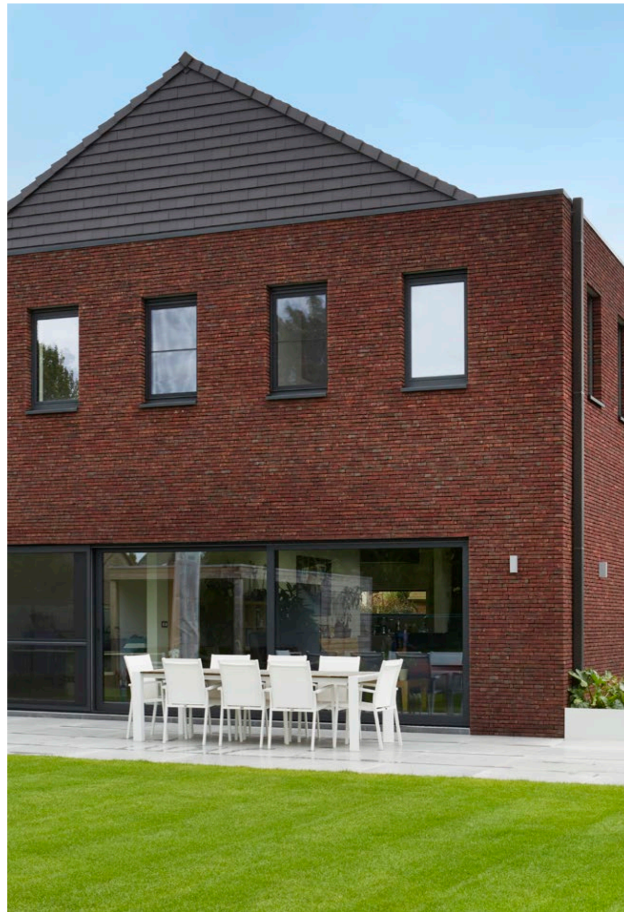
Gevel: Terca Classo Blauw-Rood Genuanceerd Gesinterd / Dak: Koramic Tegelpan Plato Antraciet mat Architectuurbureau Steven Van Hecke, Zele
