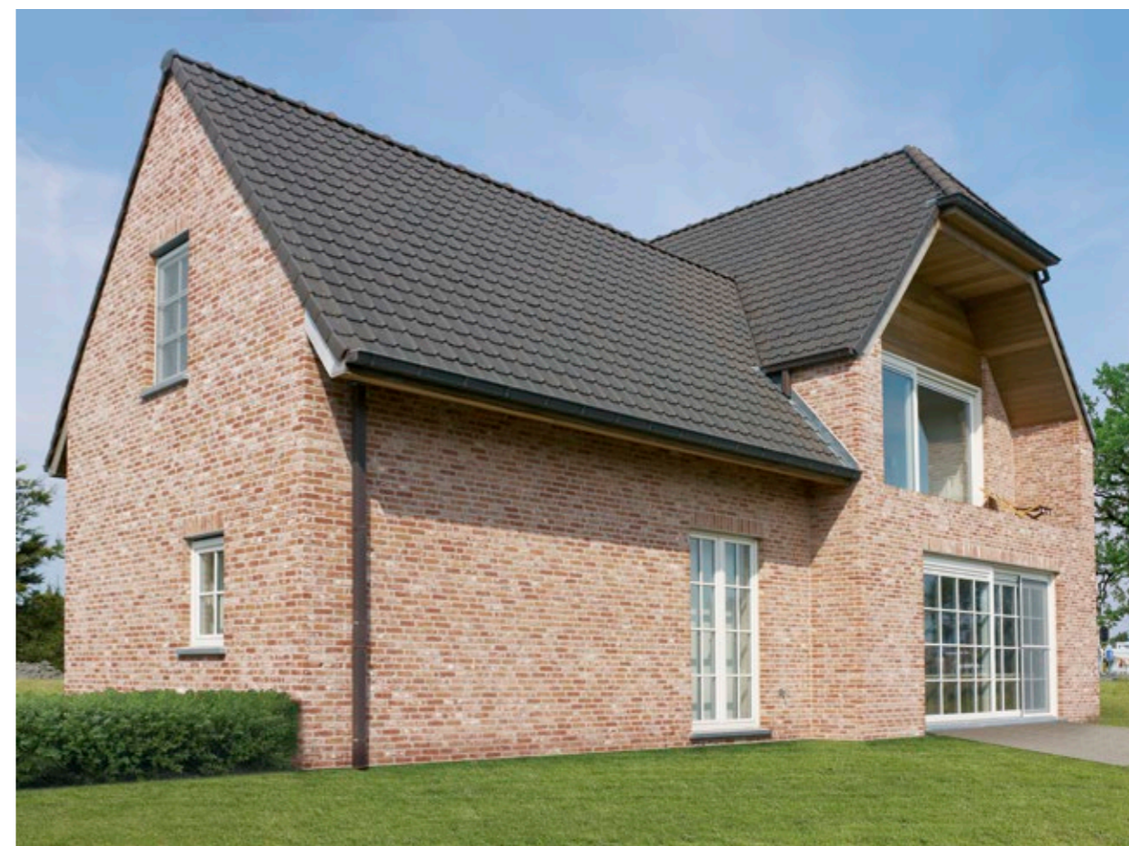
Gevel: Terca Recup Tongerse Rijnvorm / Dak: Koramic Stormpan 44 Oud Koper Architecten Cottreel & Debrabander, Ieper
