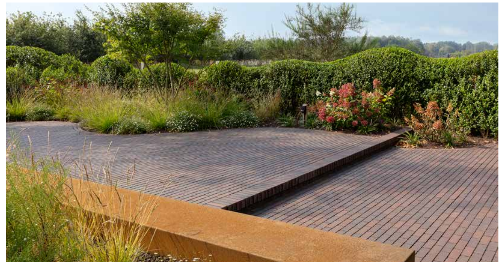
Een waterpasserende verharding zoals Passaqua verzekert een vlotte infiltratie van regenwater in de ondergrond met behoud van het gebruikscomfort. Tuinaanneming Trenson, Adegem
