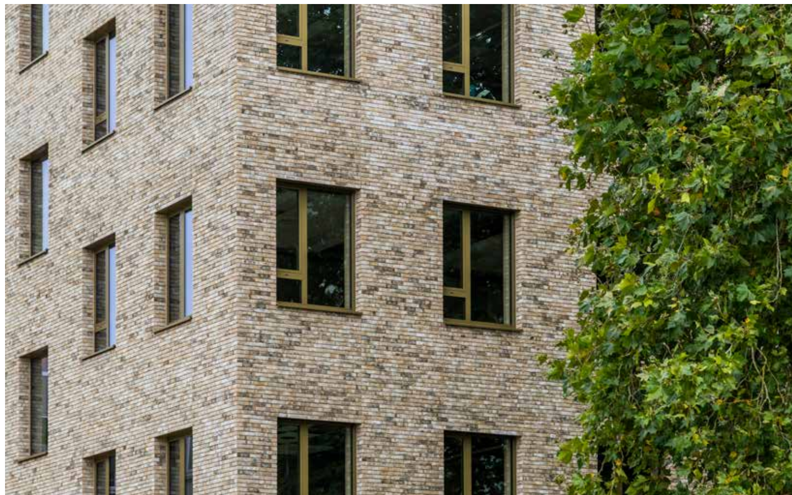
KU Leuven paste de ClickBrick Pure Brons Rustiek toe in een circulair pilootproject, de uitbreiding van een onderzoeksgebouw voor het departement Wiskunde.
